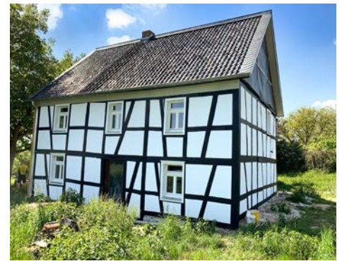
Finden Sie den Unterschied: Der Fischerhof vor und nach der Sanierung.
